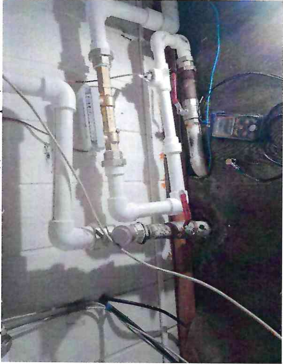
Ввод Т1, Т2 диаметр труб 42 мм
